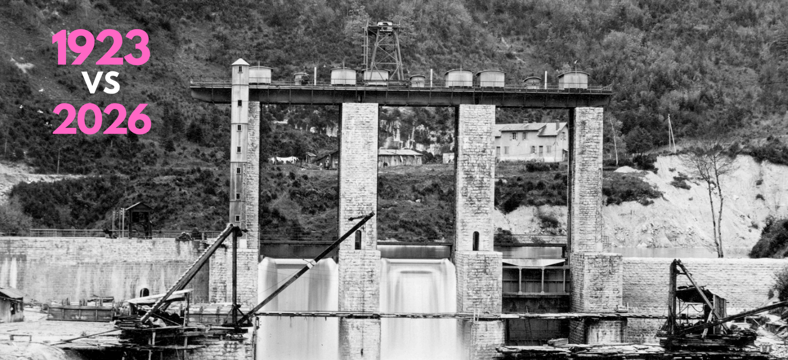
Vue en amont du barrage de la Chartreuse, avec l'une des vannes nettement visible à droite. Source : Bernard Hostache, Association ASPHOR.
