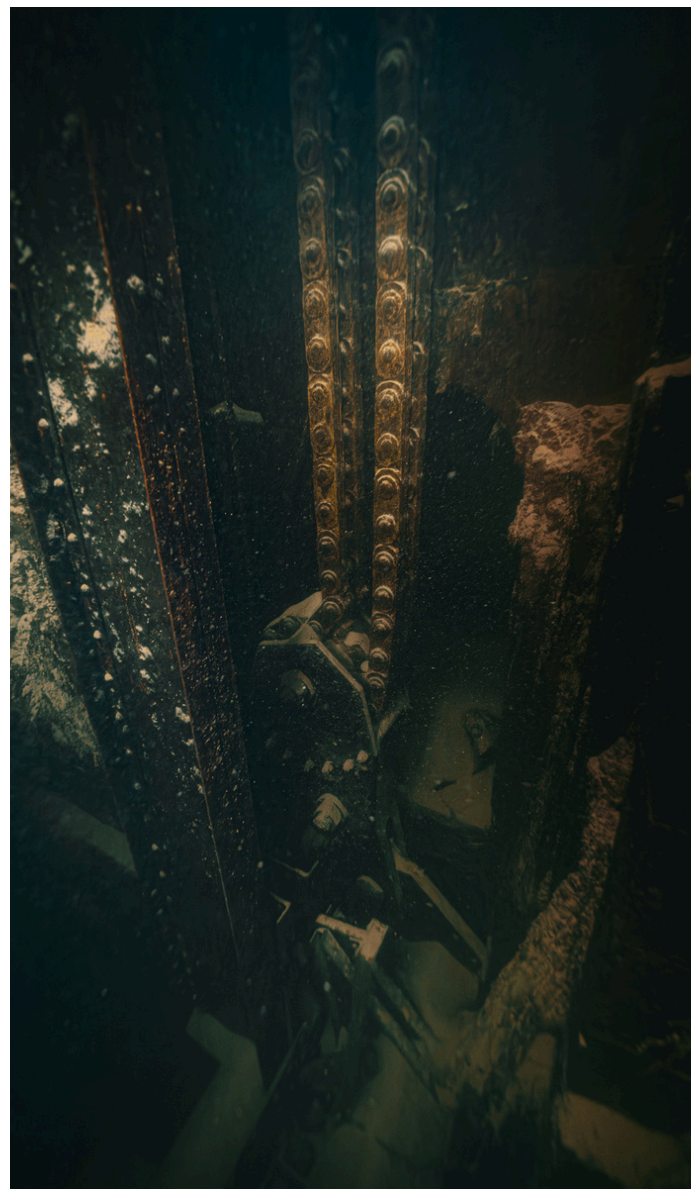
Les chaînes de levage sont encore reliées à la partie supérieure de la vanne, qu'elles permettaient de soulever lors des manœuvres. © André PiedPalmé.
