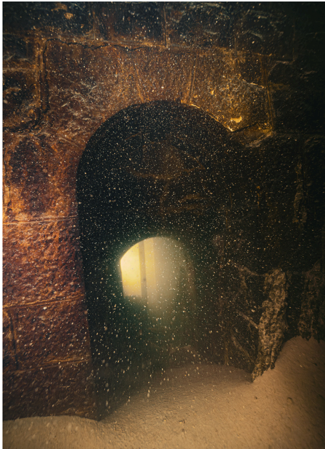
Ouverture voûtée au pied d'une pile, aménagée dans une maçonnerie de pierre de taille et traversant l'ouvrage. À contre-jour, on distingue également l'une des chaînes de levage. © André PiedPalmé.
